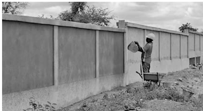
Abschlussarbeiten an der Einfriedung in Piéla (Foto: Yenfaabima)
